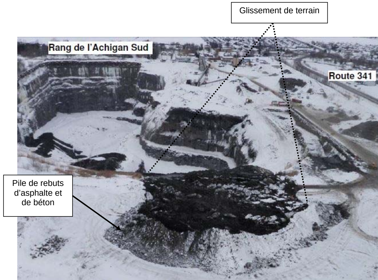
Photo 3 – Photo aérienne du site (Source : MTQ, modifiée par la CSST)
