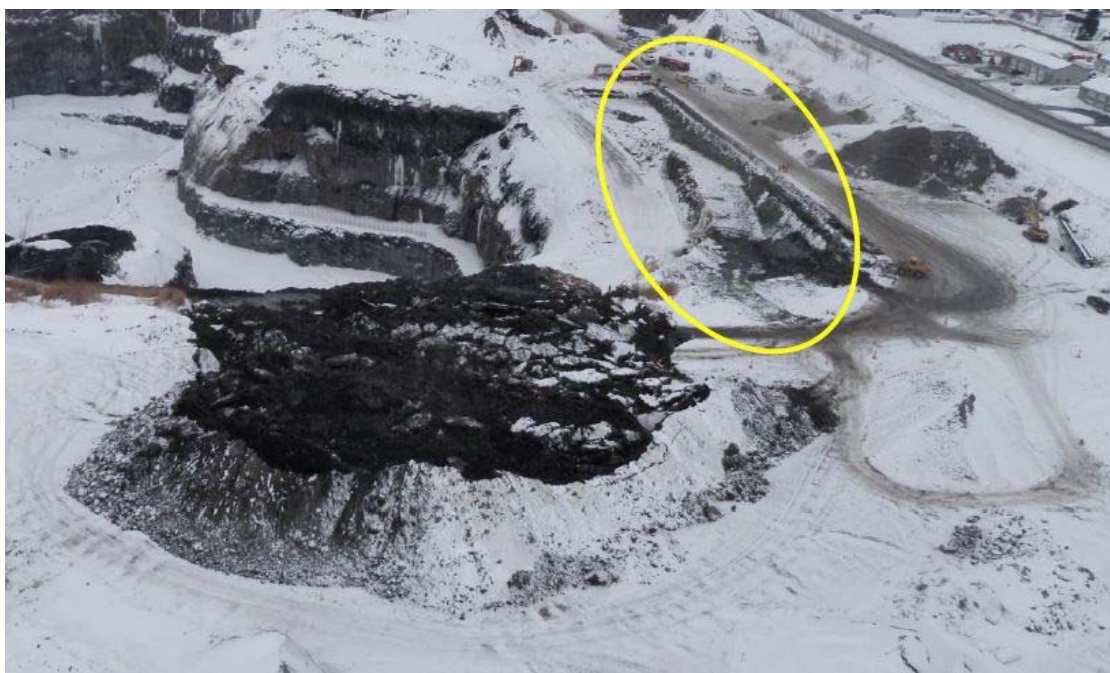
Photo 7 - Vue des travaux de décapage du roc qui ont été réalisés à partir du 14 janvier 2013 (cercle jaune). (Source : MTQ, modifiée par la CSST)
