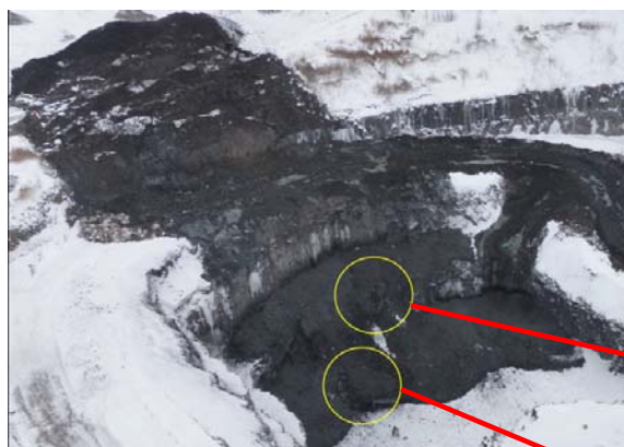
Photo 1 – Aperçu des lieux de l'accident (vue aérienne) (Source : MTQ, modifiée par la CSST)
