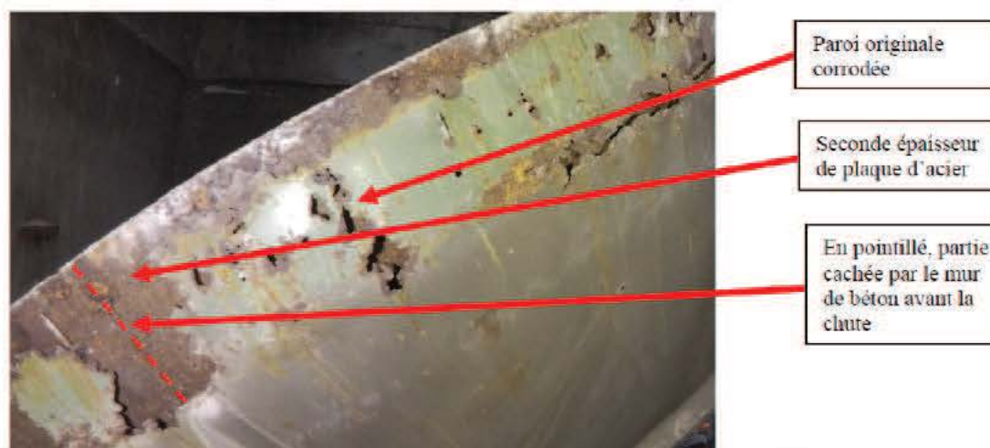
Fig. 6 – Partie supérieure de la trémie n° 1 corrodée
