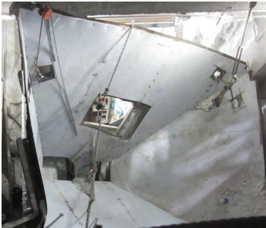
Fig. 3 – Vue aérienne de l'intérieur de la trémie n° 1 après la chute Source : CNESST
