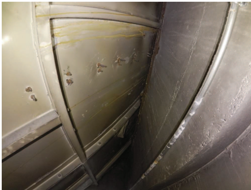
Fig. 8 – Trémie n° 2 vue du dessous. Configuration identique à la trémie n° 1 avant sa chute Source : CNESST
