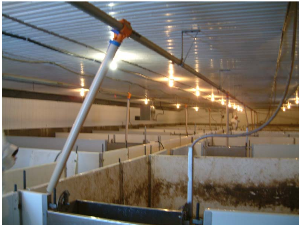
Photo 3 : vue des parcs dans la 2 e chambre d'engraissement Source : CSST
