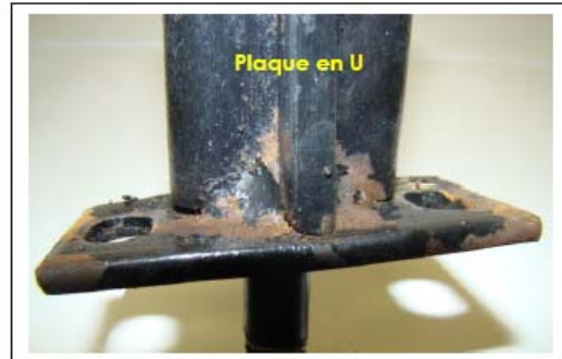
Photo 8. Plaque en U soudée partiellement sur la barrure de 2003.
