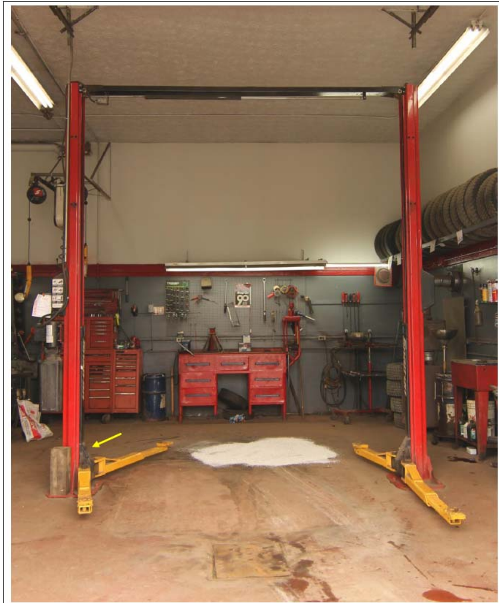
Photo 1. Système de levage et emplacement de la barure brisée (flèche jaune).
