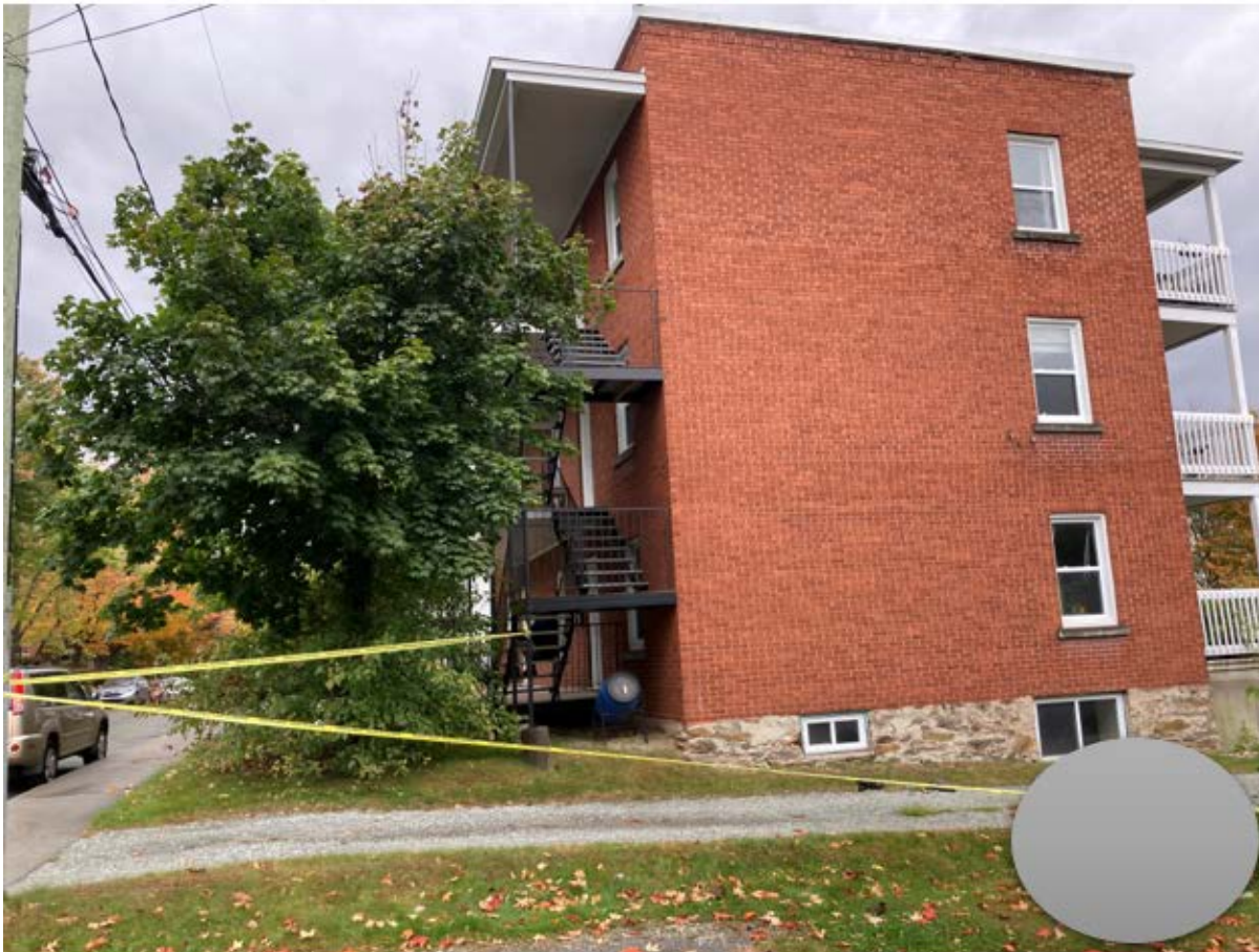
Figure 1 - Photographie de la scène de l'accident Source : CNESST
