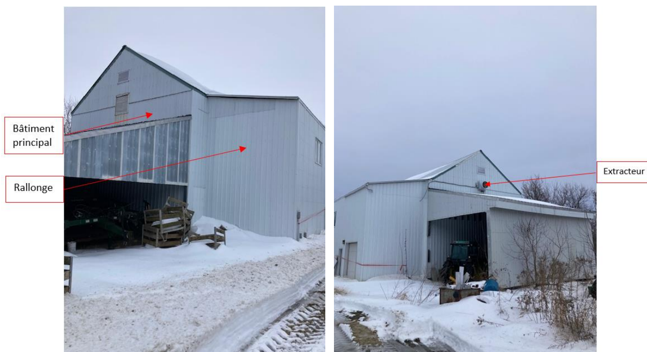
Fig. 3 et 4 - Photographies du bâtiment de traitement de l'eau Source : CNESST
