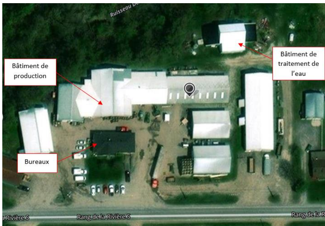
Fig. 2 - Vue aérienne des installations de l'entreprise Les patates Turcot inc. Source : Mapquest, modifiée par la CNESST
