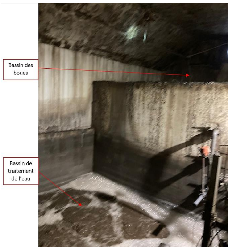
Figure 1 - Photographie des bassins de traitement de l'eau et des boues
