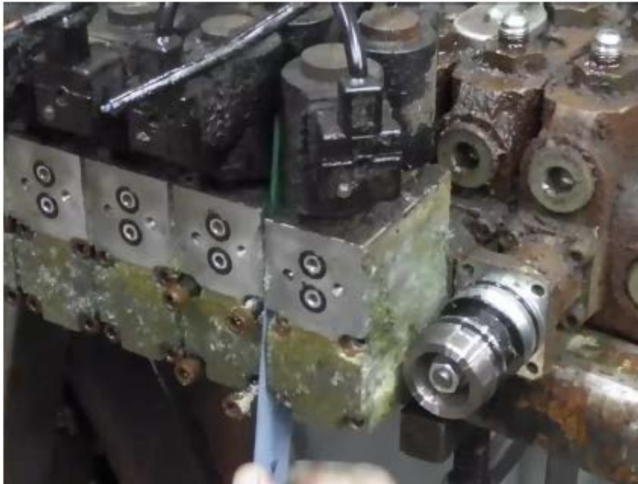
Photographie 21 Nous avons dû couper l'accumulation de corrosion à l'aide d'une lame de scie afin désinstaller les boîtiers individuellement
