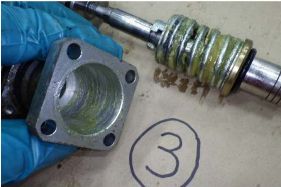
Photographie 68 Ressort de rappel n° 3 sans anomalie et adéquatement lubrifié
