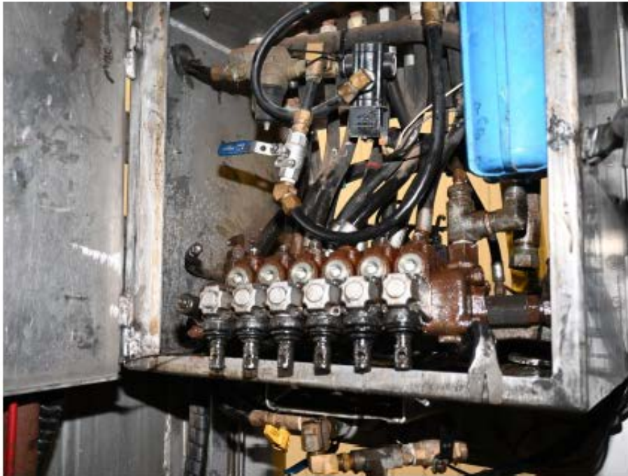
Photographie 11 Désinstallation et prélèvement du distributeur hydraulique
