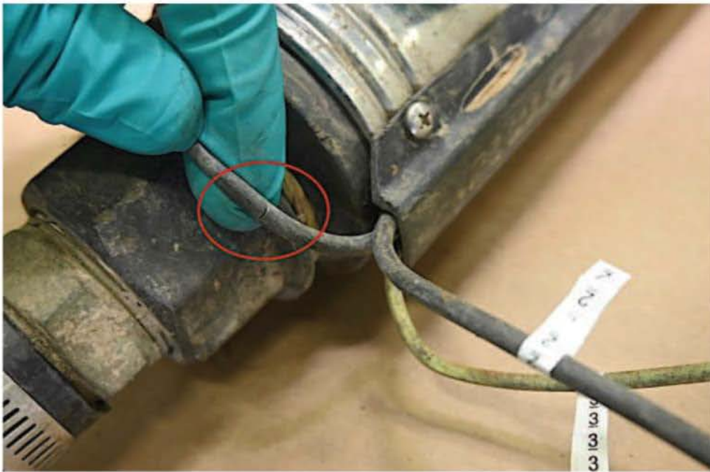
Photographie 7 Fissure dans la gaine
