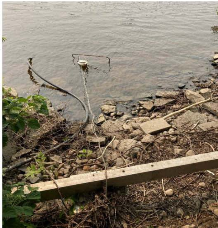
Figure 1 - Bord de la rivière avec la pompe submersible partiellement installée
