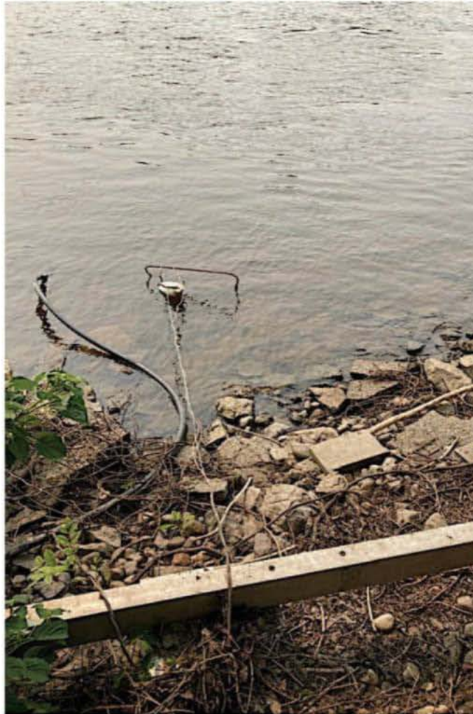
Photographie 1 Pompe dans la rivière des Prairies (photographie fournie par la CNESST)
