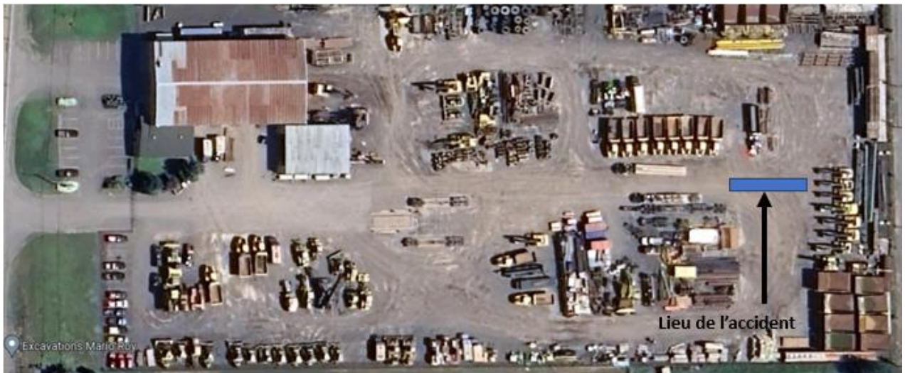
Fig. 4 - Cour de chargement et de déchargement d'Excavations Mario Roy inc. Source : Google Maps, carte modifiée par la CNESST
