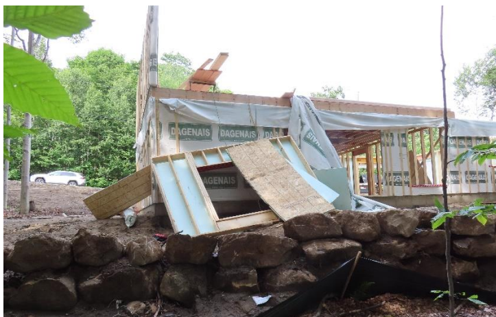
Fig. 4 - Muret en pierre Source : CNESST
