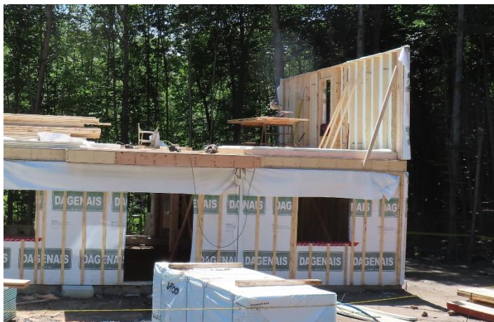
Fig. 5 - Mur du côté droit
