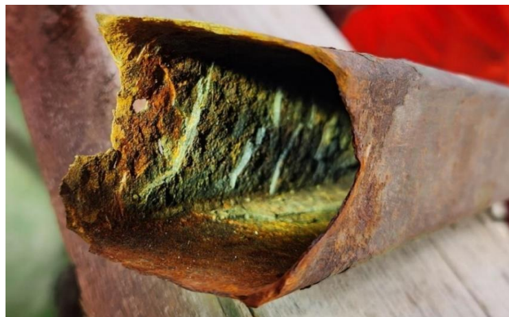
Fig. 24 - Membrane 3 corrodée et rompue Source : CNESST
