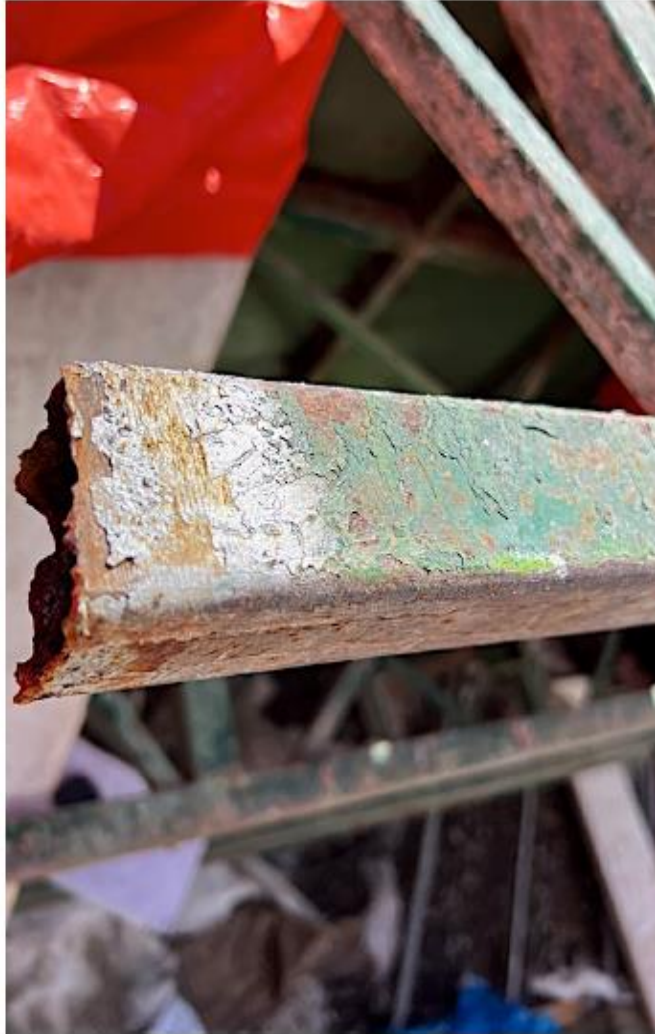
Photographie 17 Surface sans préparation pour soudure
