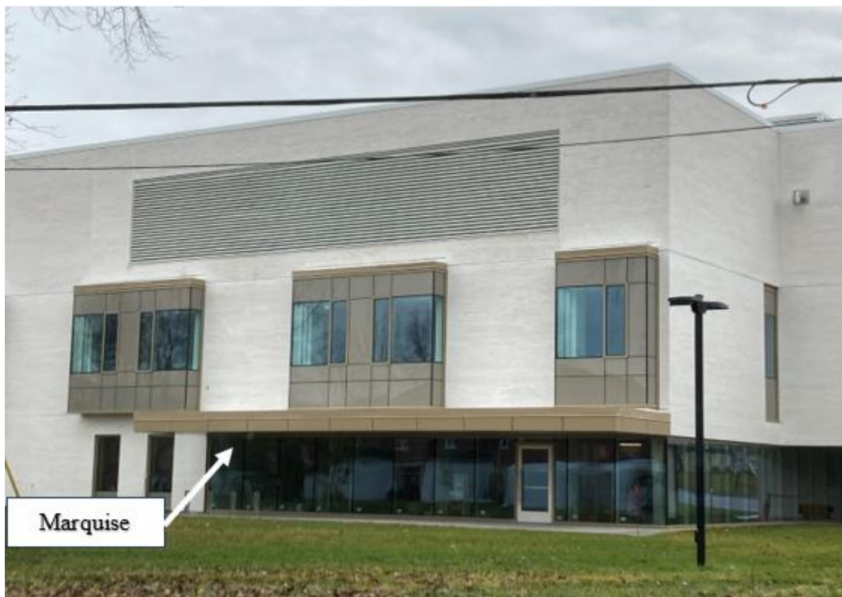
Fig. 4 - Lieu de l'accident – Travaux sur le bâtiment terminés
