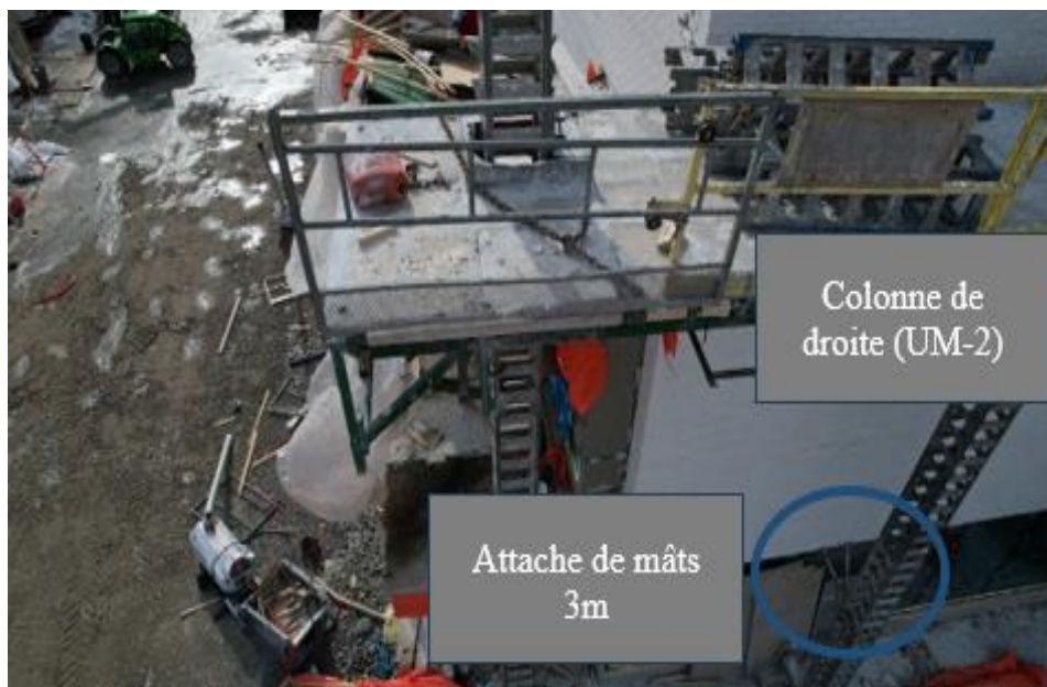
Fig. 10 - Amarrage de l'unité motorisée UM-2 Source : CNESST
