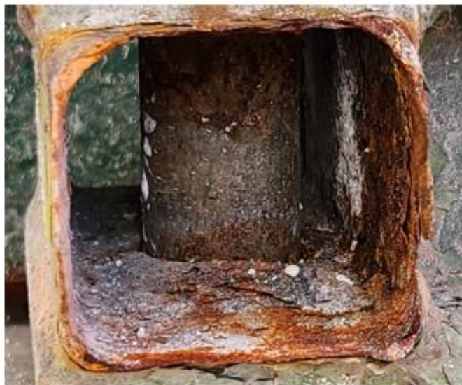
Photo 18 - Section transversale de la membrure 3 (source CNESST)
