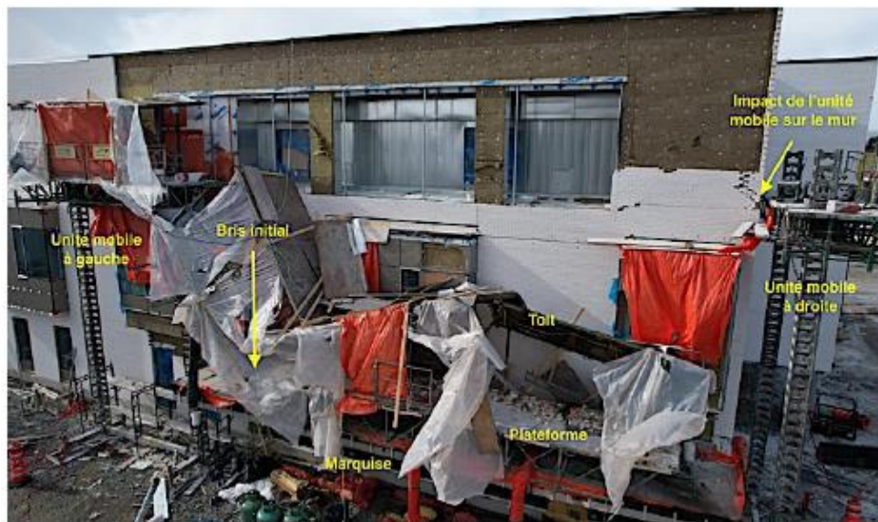
Photographie 1 Échafaudage au complet
