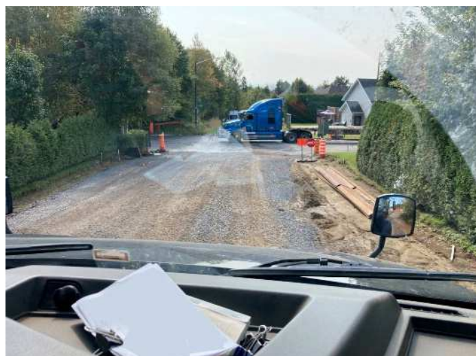
Fig. 30 – Vue de l'intersection à partir du camion sortant
