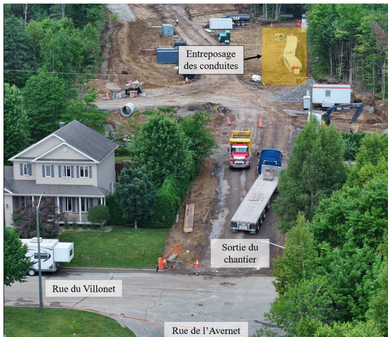
Fig. 9 – Zone d'entreposage des conduites de béton Source: CNESST
