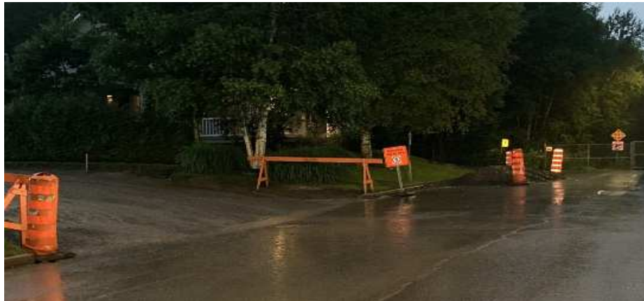
Fig. 26 – Signalisation à la sortie du chantier sur la rue du Villonet Source : CNESST
