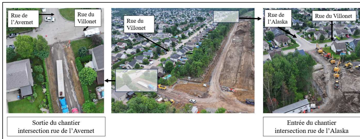
Fig. 4 – Entrée et sortie du chantier Source: CNESST
