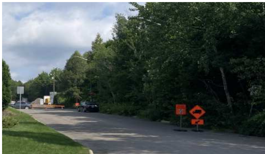
Fig. 28 – Signalisation sur rue de l'Avernet vers la sortie du chantier Source : CNESST
